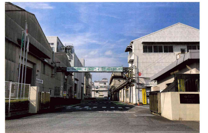
旭有機材株式会社延岡工場
