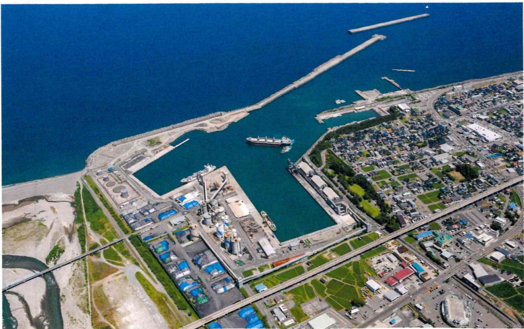
セメント・石灰石出荷の物流拠点である姫川港
