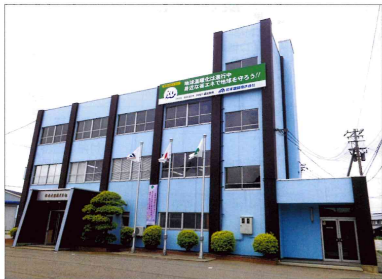
松本建設株式会社全景
