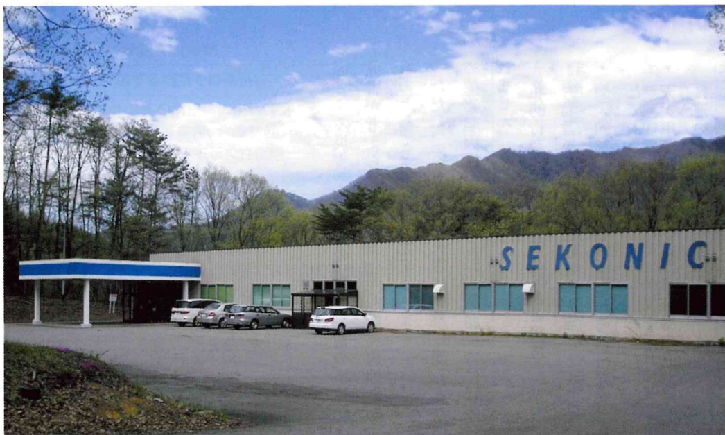
会社社屋(南会津工場)
