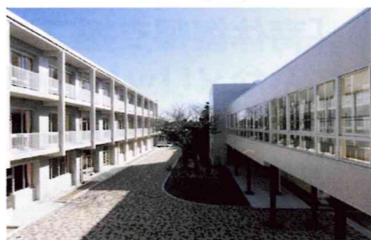
蛸塚中建設工事
