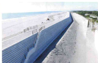
防潮堤整備工事
