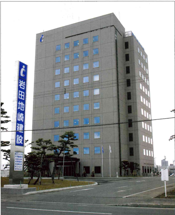
岩田地崎建設株式会社社屋
